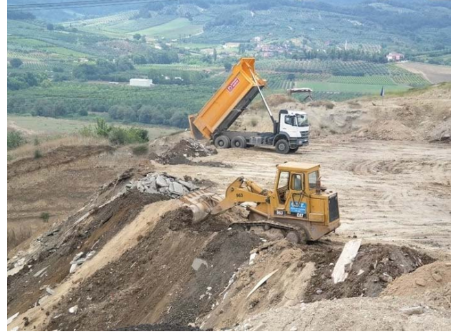
Şekil 3, 3. Havalimanı inşaatı sırasında Ağaçlı Köyü Hafriyat alanları, Kaynak: Sözcü Gazetesi, 2020
